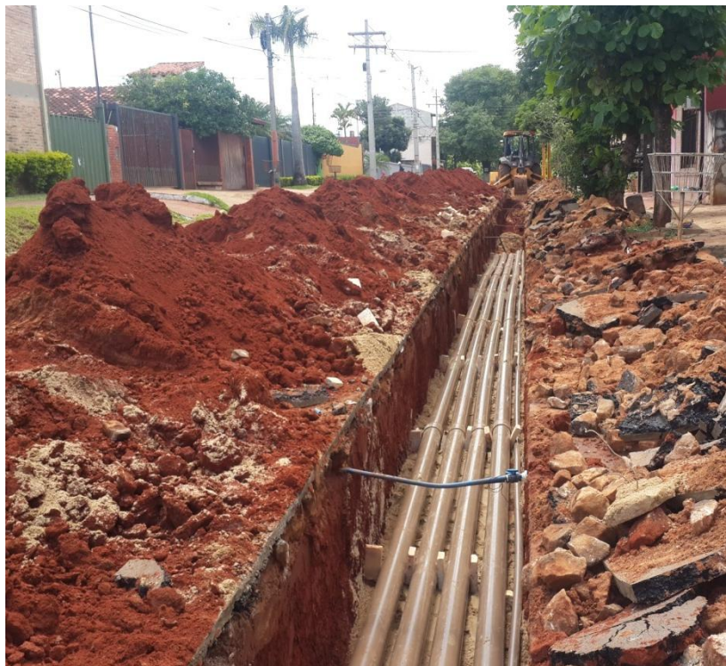
Construcción de LT Subterránea 66 kV - Refuerzo del Sistema Metropolitano – San Lorenzo - Fernando de la Mora, Licitación Pública Nacional ANDE N° 1230/2016 - Lote 1 - BONOS I
